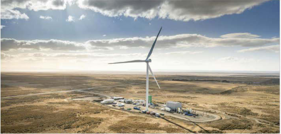
Die unter anderem von Porsche eingerichtete Pilotanlage Haru Oni in Chile wurde kürzlich in Betrieb genommen. Hier sollen bald 55 Millionen Liter E-Fuel pro Jahr aus den dicken Leitungen laufen
